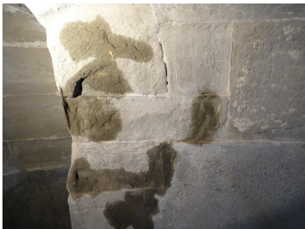
Foto 7,8: Prima applicazione localizzata di silicato di etile per la riagggregazione della matrice lapidea.
