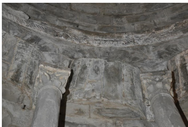
Foto3,4: superficie lapidea dell'abside con evidenti efflorescenze bianche e macchie carbonatiche
