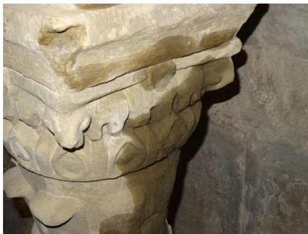
Foto 7,8: Prima applicazione localizzata di silicato di etile per la riagggregazione della matrice lapidea.
