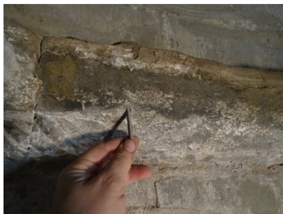
Foto 18: inserimento di un pernio filettato per il bloccaggio della porzione della cornice marcapiano.
