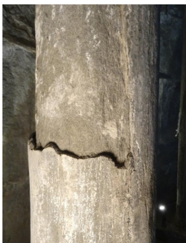
Foto 12,13: Zona di distacco su un colonna sottoposta a trattamento di silicato di etile, punti di fermatura ed iniezioni con malta e resina e successiva stuccatura a scarpa della cavità.
