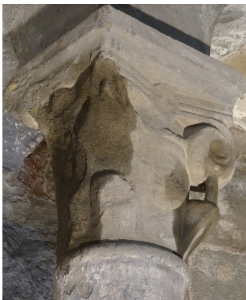
Foto 9,10: Zone coinvolte dall'applicazione di vari passaggi di silicato di etile
