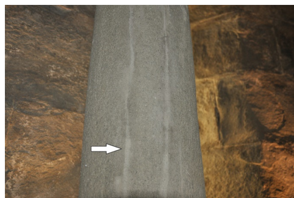
Foto 19,20,21,22: dopo il consolidamento con silicato di etile (19) dei bordi delle mancanze si sono effettuate le stuccature "a scarpa" di rinforzo (20-22) oltre che delle lesioni come indicate dalle frecce sulle immagini.
