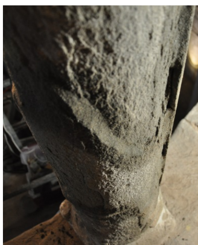
Foto 12,13: Zona di distacco su un colonna sottoposta a trattamento di silicato di etile, punti di fermatura ed iniezioni con malta e resina e successiva stuccatura a scarpa della cavità.
