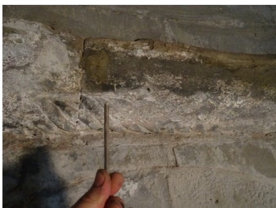
Foto 18: inserimento di un pernio filettato per il bloccaggio della porzione della cornice marcapiano.
