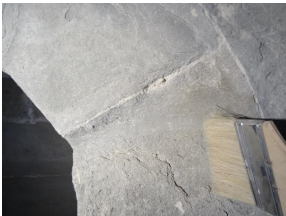
Foto 5,6: Spolveratura e rimozione dei depositi dalla superficie
