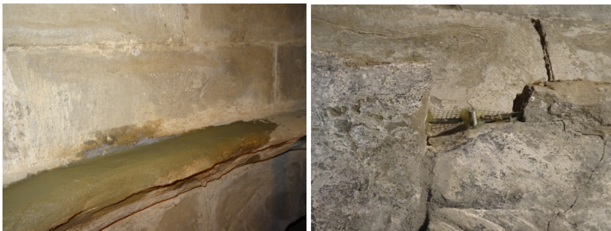
Foto 25: Stuccatura della porzione di cornice imperniata con l'applicazione a rinforzo di rete in fibra sintetica. La stuccatura pigmentata ha raggiunto la cromia della superficie originale dopo la completa asciugatura.
