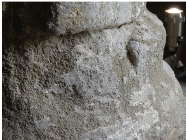
Foto 1,2: presenza di scialbi a base di calce sulla superficie lapidea dei capitelli
