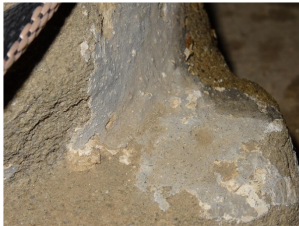
Foto 1,2: presenza di scialbi a base di calce sulla superficie lapidea dei capitelli
