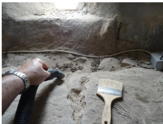
Foto 5,6: Spolveratura e rimozione dei depositi dalla superficie
